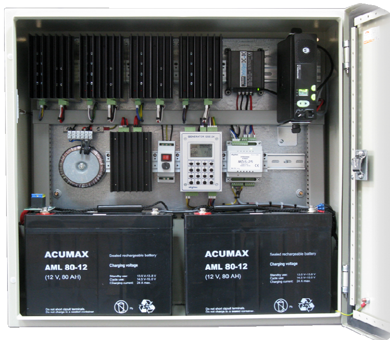
Przykładowy blok sterujący syreny DSE o mocy 1200W
